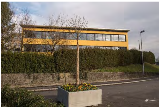
Das Ettiswiler Schulhaus 2003 soll aufgestockt werden
