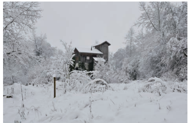
Das alte Kiesturmgebäude im Winterkleid, Dezember 2020.
