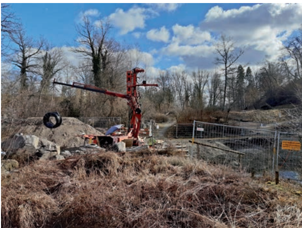
Mit diesem Bohrer wurde das Loch für die Erdsonde ausgehoben.
