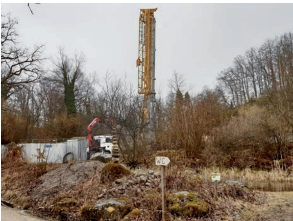
Der Baukran wird für die Hochbauarbeiten aufgebaut.
