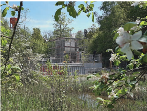
Deutlich wird der Turm des Neubaus erkennbar.
